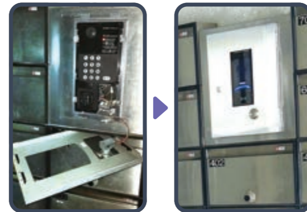
壊れたオートロックの取替施工事例
