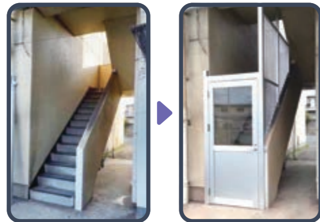
階段の施工事例
