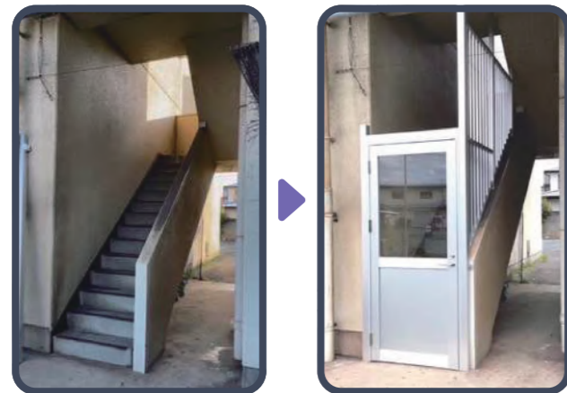
階段の施工事例
