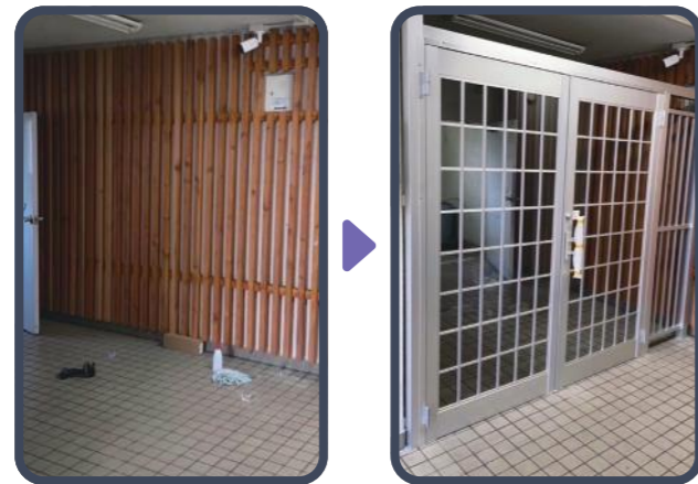
門扉の施工事例1
