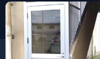
施工後 (集合玄関機)
