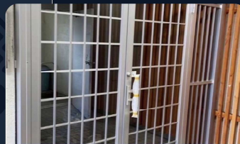
施工後 (集合玄関機)
